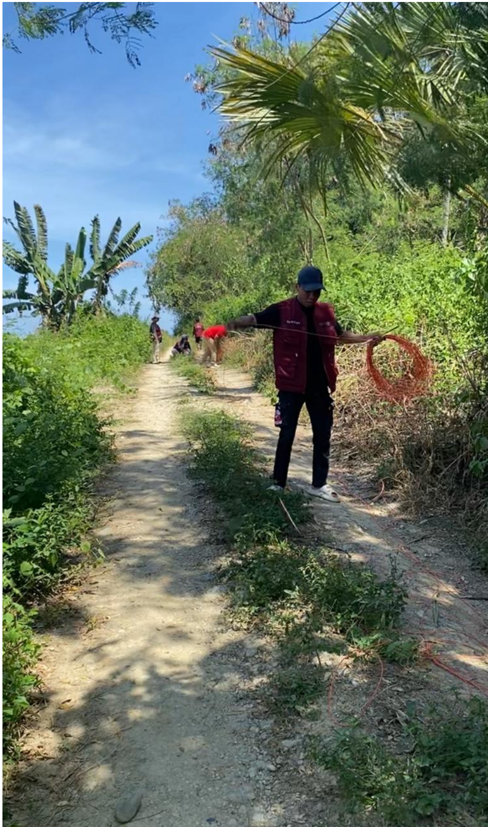
Gambar 7. Pemasangan Kabel oleh Mahasiswa
