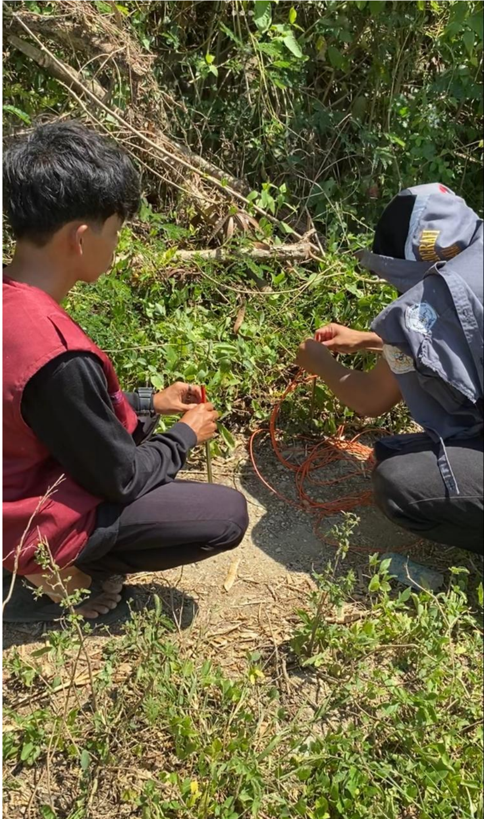
Gambar 8. Pengikatan Kabel ke Batangan Tembaga
