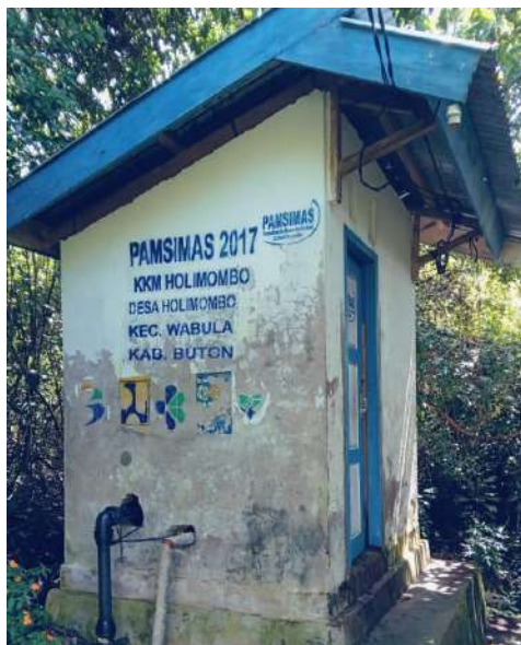
Gambar 2.1 Rumah Mesin Air
