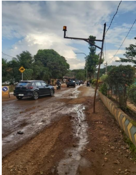
Gambar 4.3. Kondisi Jalan Raya Desa Hakatutobu
