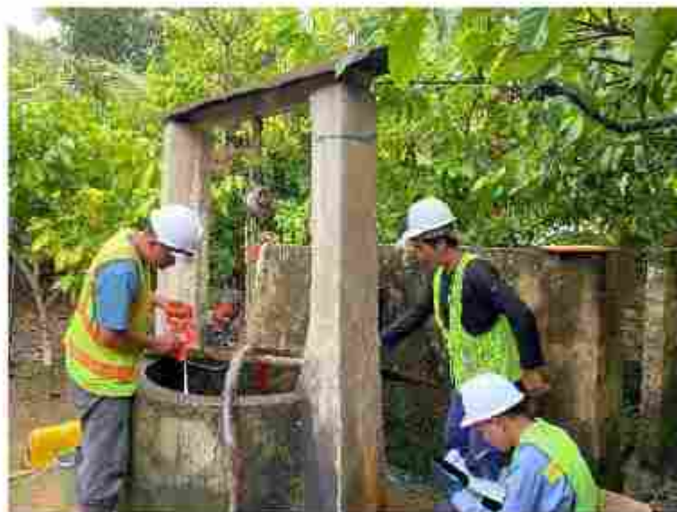
Gambar 5.9 Foto Pumping Test Pada CAT Ewolangka
