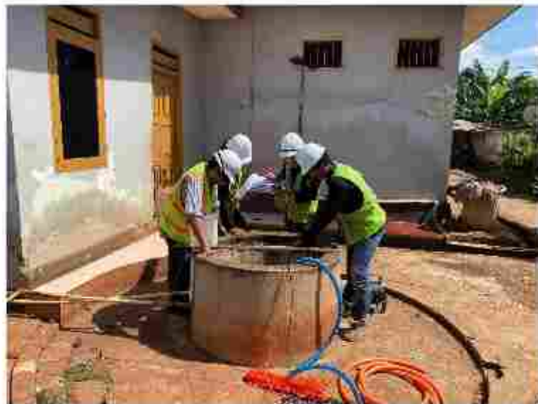
Gambar 5.3 Pengambilan Data Sumur Uji Pompa
